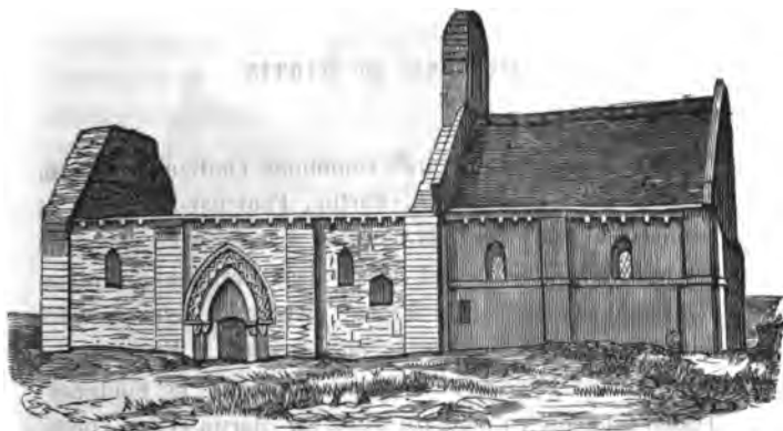
ÉGLISE D'ÉTAVAux AVANT QU'ELLE FUT RÉPARÉE.
